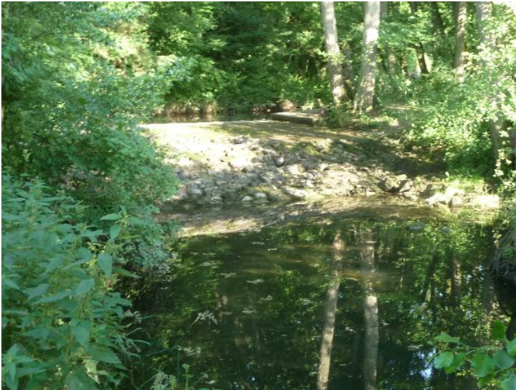
Rampe und Staustufe
