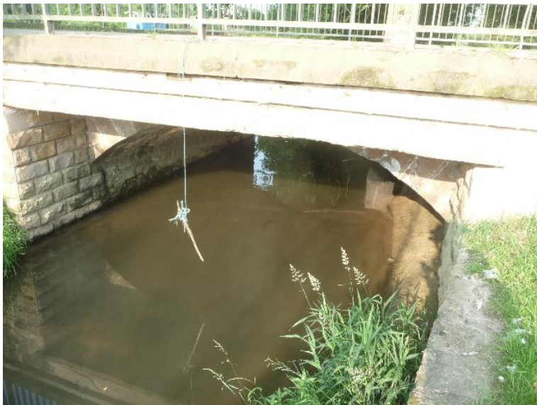
Durchlass; Ufer unterbrochen
