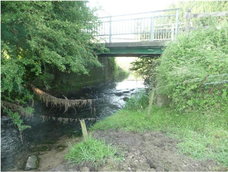
Durchlass; Ufer unterbrochen
