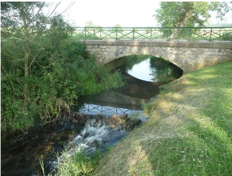
Durchlass; Ufer unterbrochen
