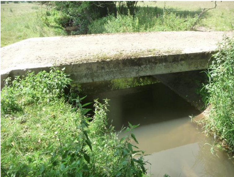
Durchlass; Ufer unterbrochen
