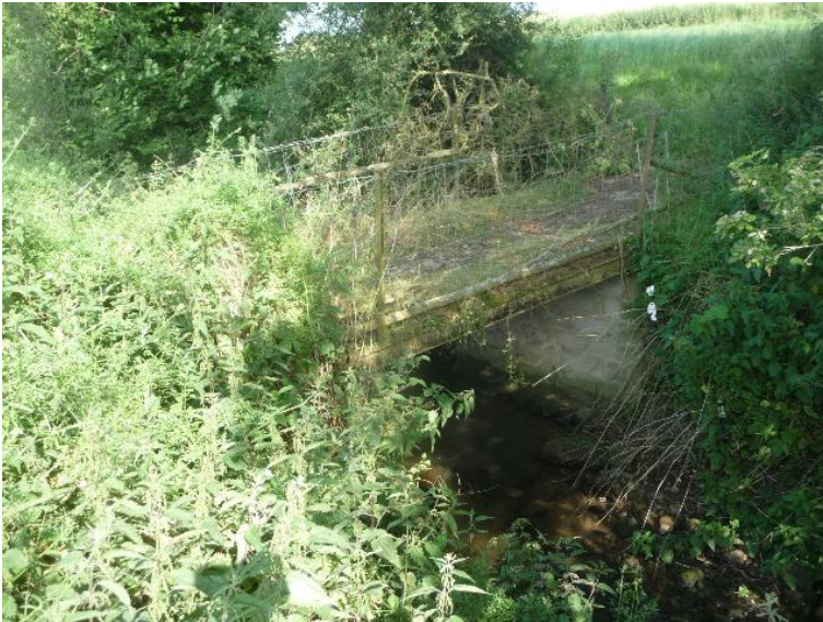
Durchlass; Ufer unterbrochen
