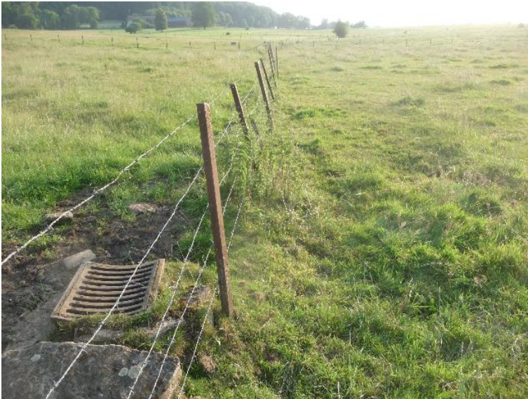
verrohrt bzw. ueberdeckt
