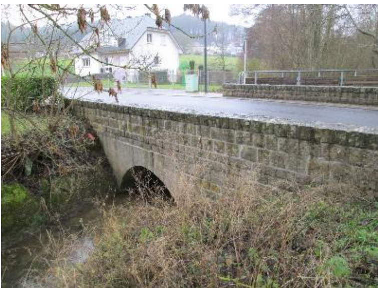
Durchlass; Ufer unterbrochen
