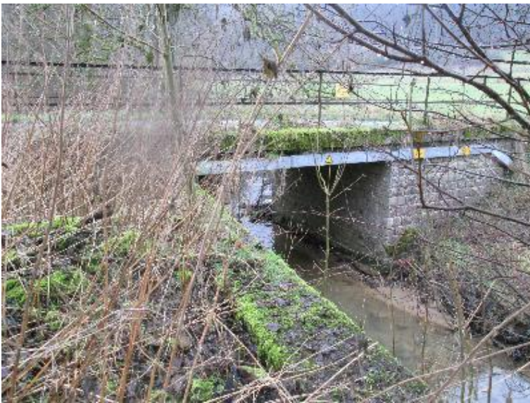
Durchlass; Ufer unterbrochen
