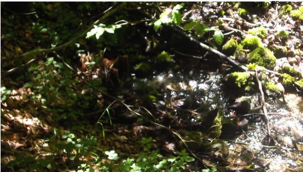
Durchlass; Lauf verengt
