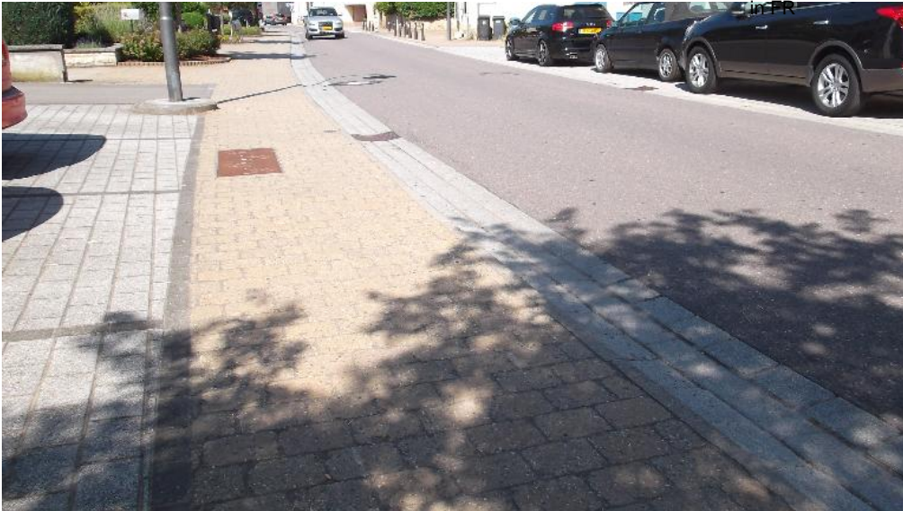
verrohrt bzw. ueberdeckt
