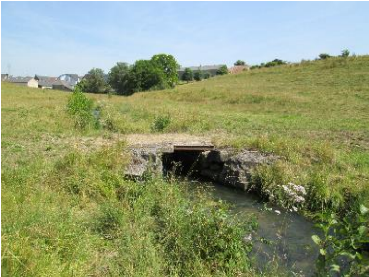
Durchlass; Ufer unterbrochen
