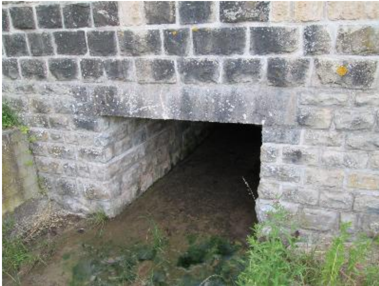
verrohrt bzw. ueberdeckt
