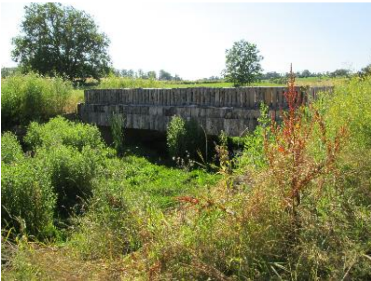
Durchlass; Ufer unterbrochen
