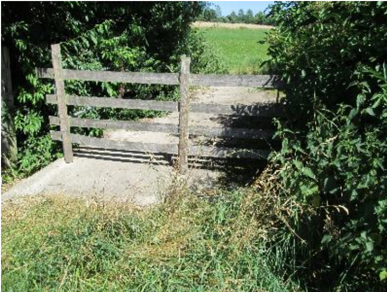
Durchlass; Ufer unterbrochen
