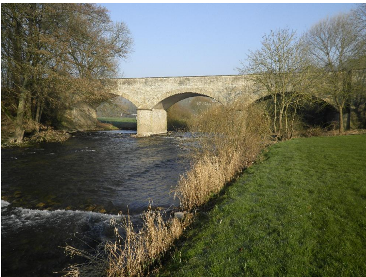
Durchlass; Ufer unterbrochen
