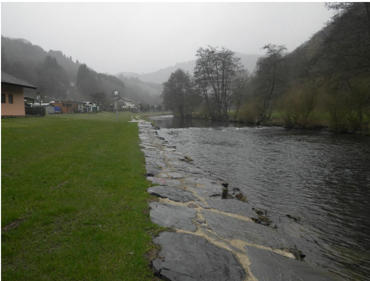
Bebauung mit Freifläche
