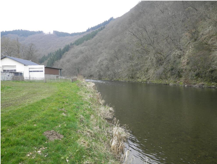
Bebauung mit Freifläche
