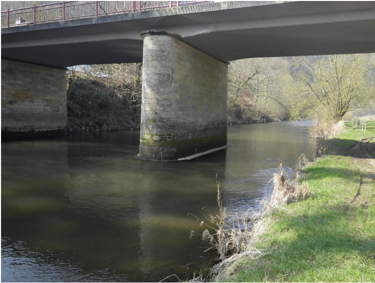
Durchlass; Ufer unterbrochen
