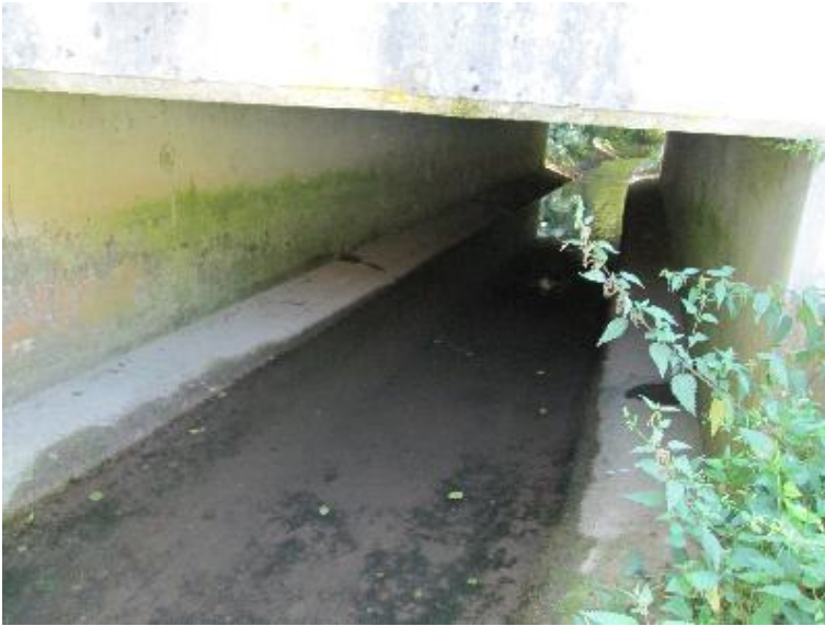
Durchlass; Ufer unterbrochen
