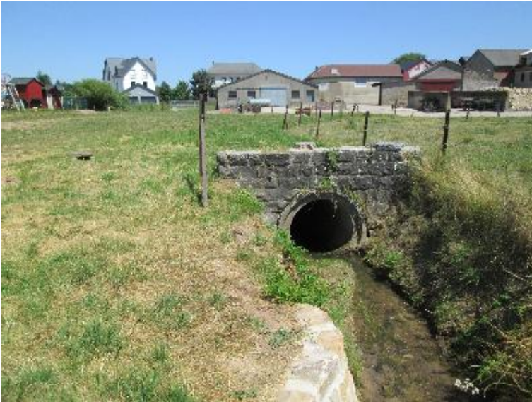
verrohrt bzw. ueberdeckt
