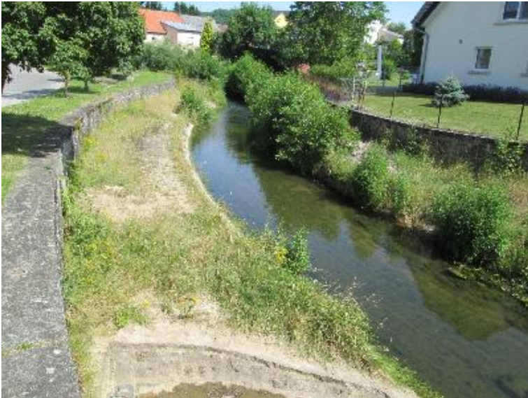
Beton, Mauer, Pflaster; verfugt
