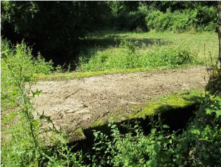
Durchlass; Ufer unterbrochen
