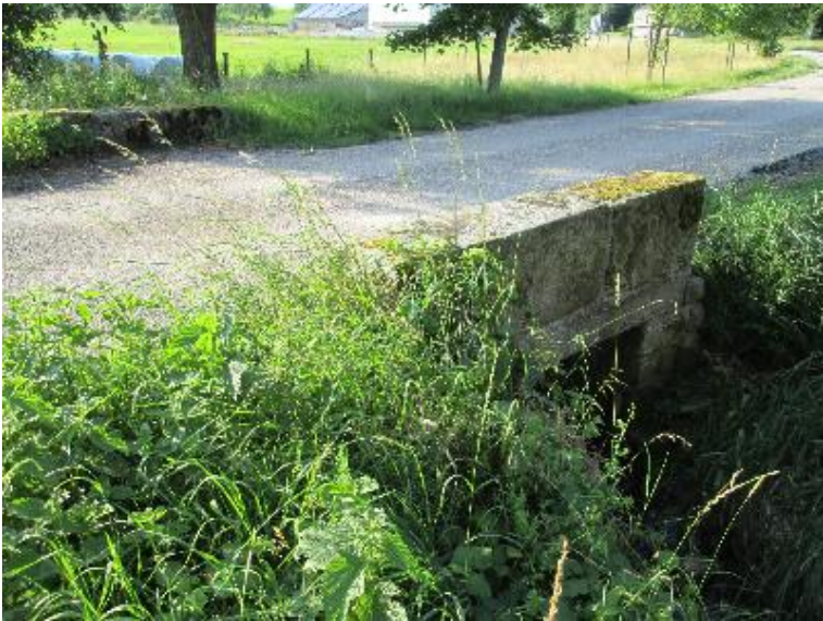
Durchlass; Ufer unterbrochen
