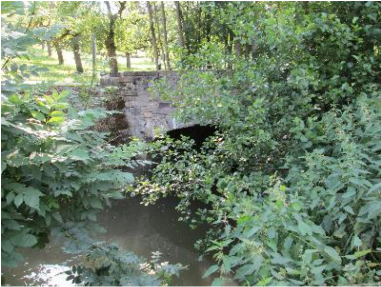
Durchlass; Ufer unterbrochen
