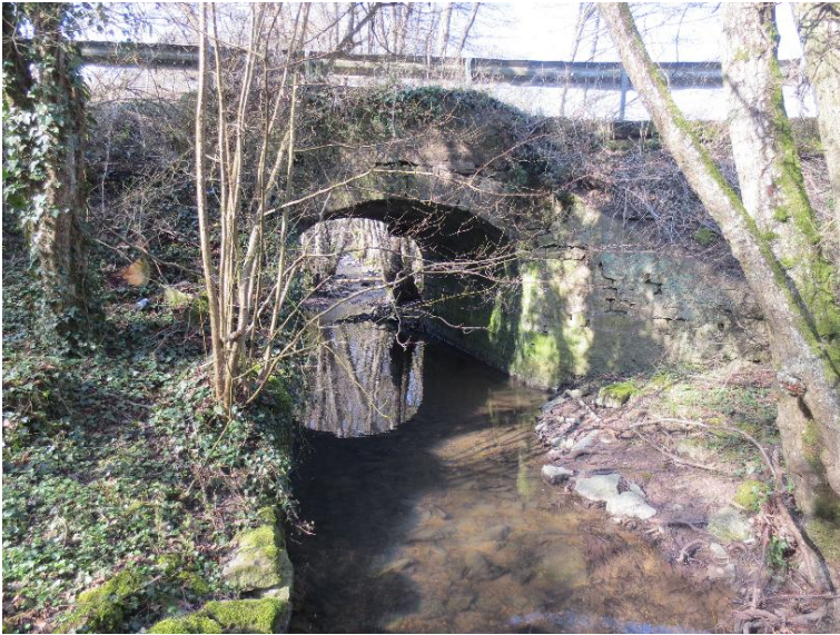
Durchlass; Ufer unterbrochen
