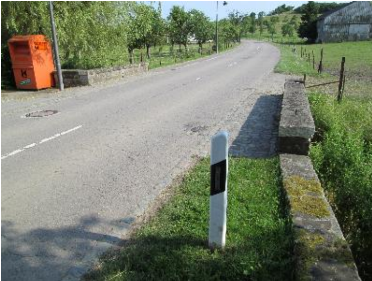
Durchlass; Ufer unterbrochen
