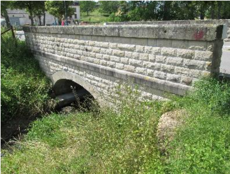
Durchlass; Ufer unterbrochen
