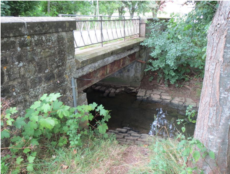
Durchlass; Ufer unterbrochen
