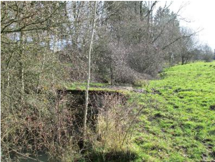
Durchlass; Ufer unterbrochen
