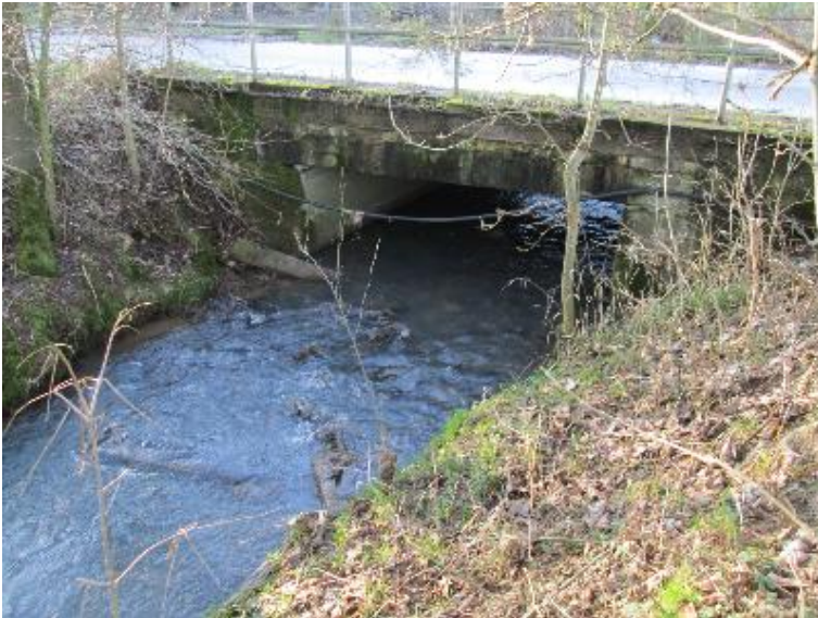
Raue Gleite - Durchlass; Ufer unterbrochen
