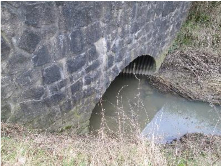
verrohrt bzw. ueberdeckt
