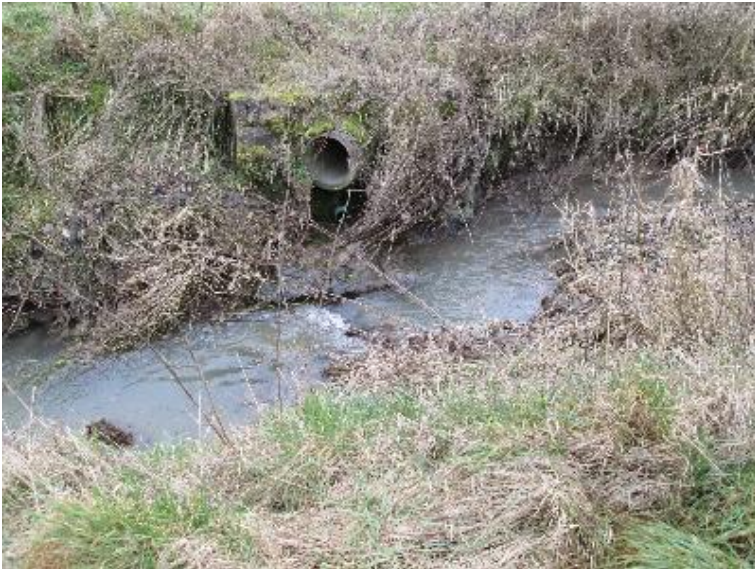
Absturz; kleiner - Einleitung
