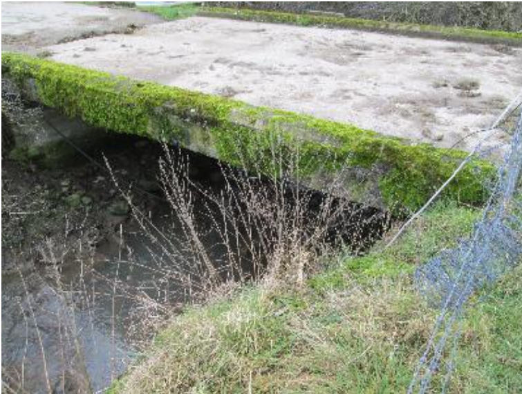
Durchlass; Ufer unterbrochen
