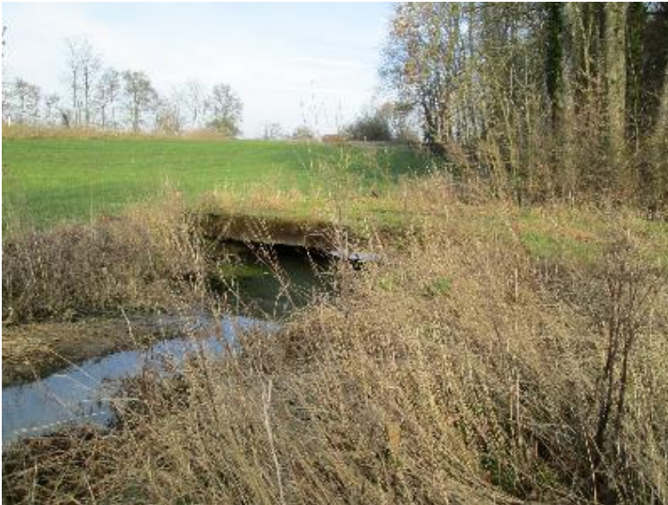
Durchlass; Ufer unterbrochen
