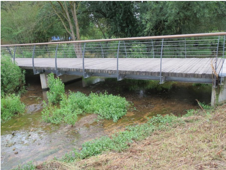
Durchlass; Ufer unterbrochen
