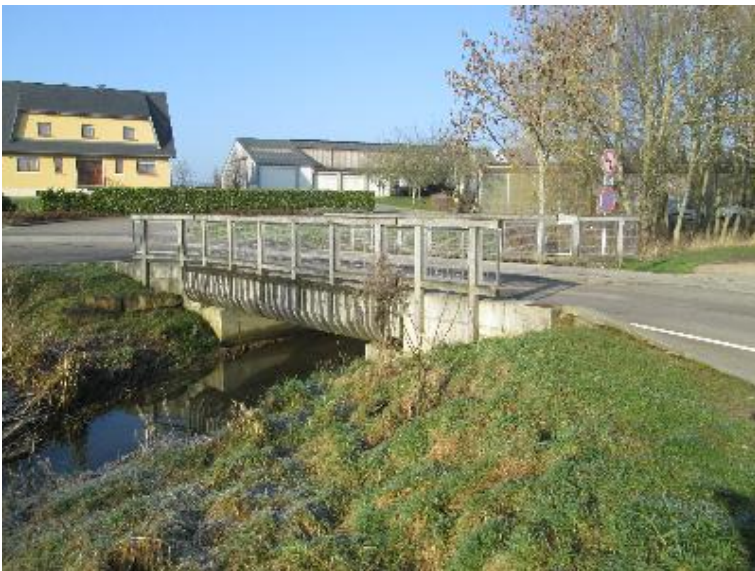
Durchlass; Ufer unterbrochen
