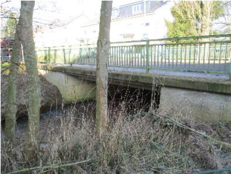
Durchlass; Ufer unterbrochen
