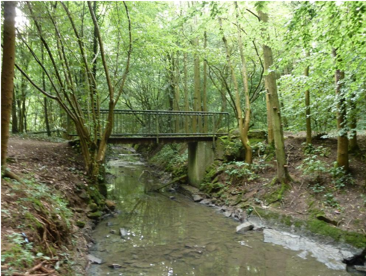
Durchlass; Ufer unterbrochen
