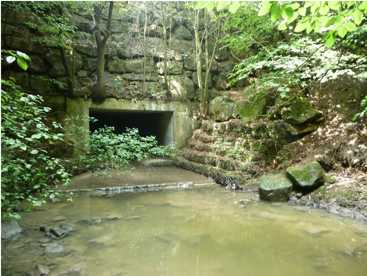
Absturz aus Verrohrung - verrohrt bzw. ueberdeckt
