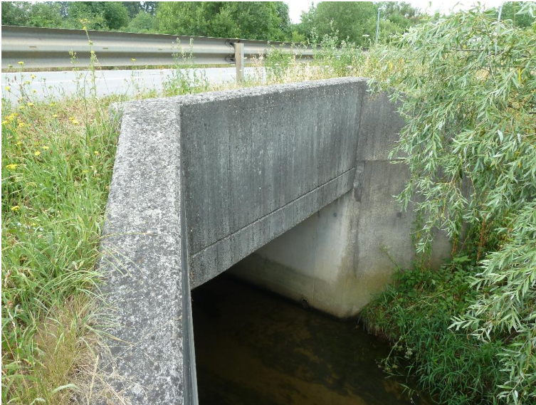
Durchlass; Ufer unterbrochen
