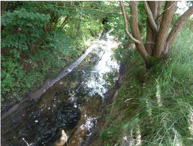
Sohlenverbau - Regelprofil; verfallenes
