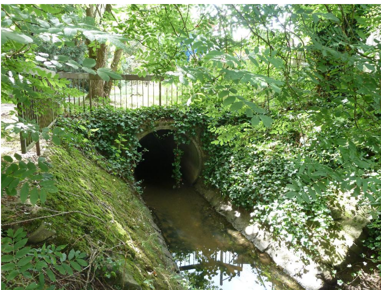
verrohrt bzw. ueberdeckt
