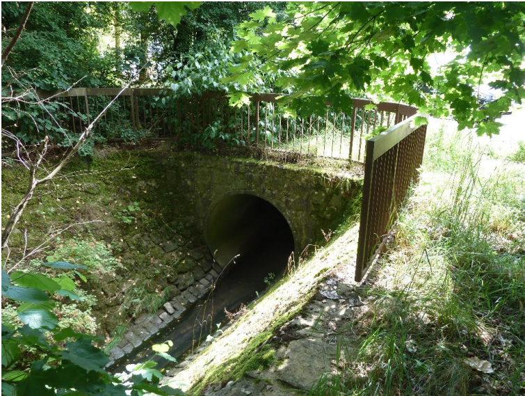
verrohrt bzw. ueberdeckt
