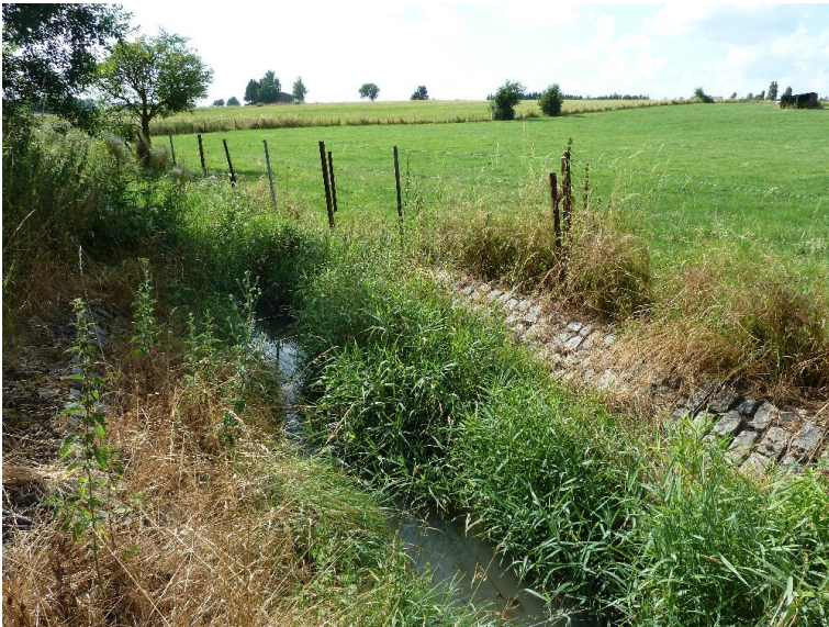
Uferverbau - Gewaesser verkraetet - Gruenland
