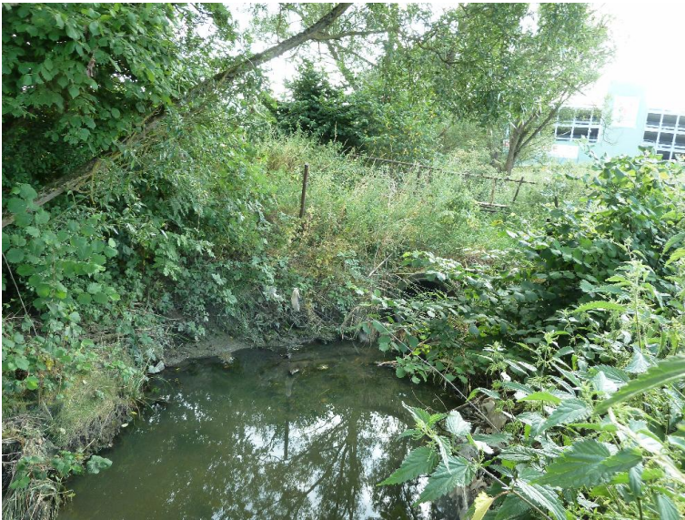
Durchlass; Lauf verengt
