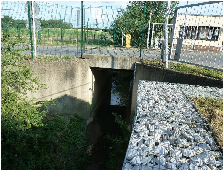
Durchlass; Ufer unterbrochen
