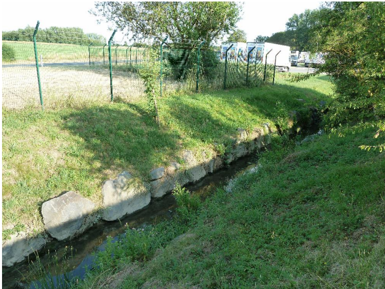
Uferbefestigung durch Steinbloেকে
