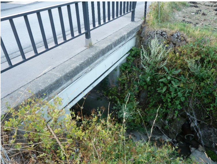
Durchlass; Ufer unterbrochen
