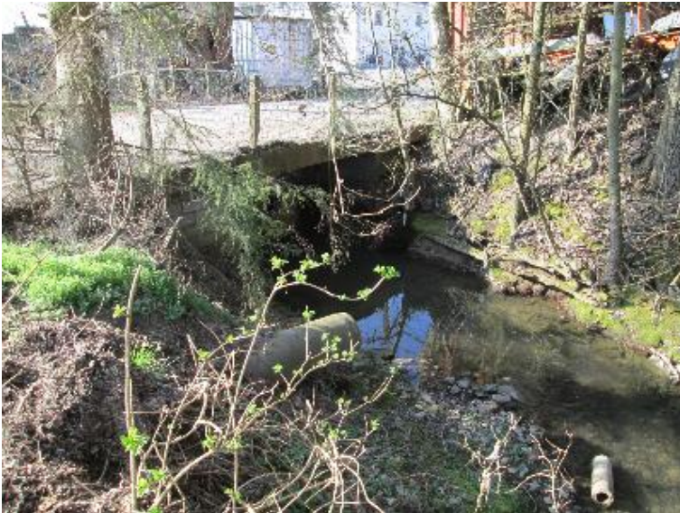
Durchlass; Ufer unterbrochen
