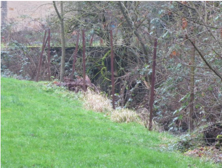
verrohrt bzw. ueberdeckt
