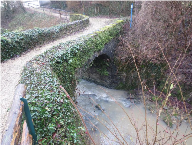
Durchlass; Ufer unterbrochen
